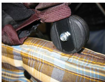
Überstehende scharfkantige Schraube im Sitzbereich
