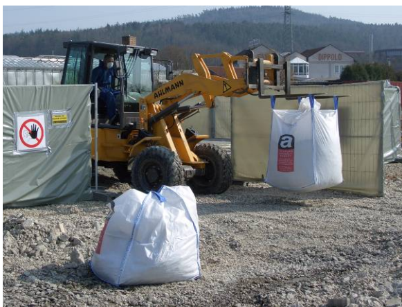
Bild 3: Sicherer Transport von korrekt verpackten und gekennzeichneten Big-Bag's mit asbesthaltigem Bauschutt
