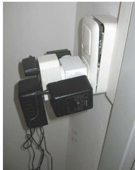
Bild 2: Kombination aus zwei Adaptern – „Christbaumbildung“
