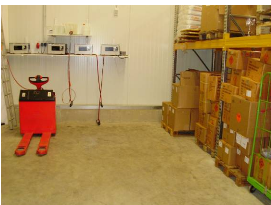
Abb. 2: Zu geringer Schutzabstand: Lagerung von Feuerwerksartikeln direkt neben Batterieladestation
