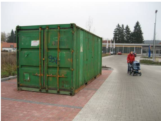
Abb. 6: Fehlende Absperrung des Brandschutzbereiches um den Lagercontainer
