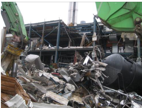
Abb. 1: Abbruch eines Stahlskelettbauwerkes
