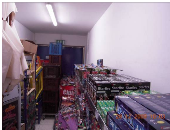
Abb. 4: Immer wieder: Verstellter Notausgang
