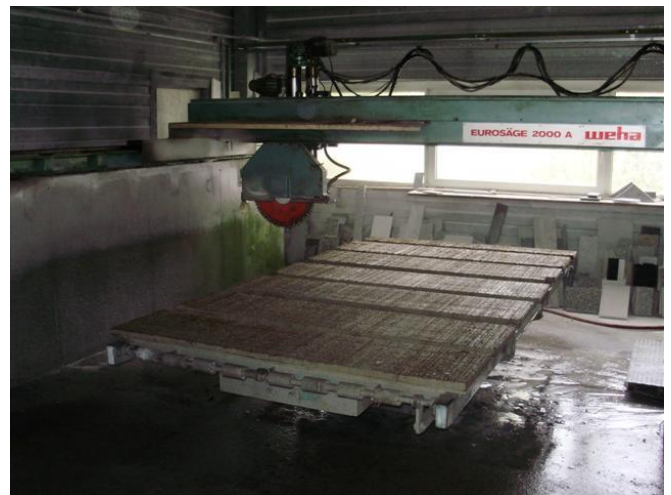
Arbeitsraum mit Brückensäge
