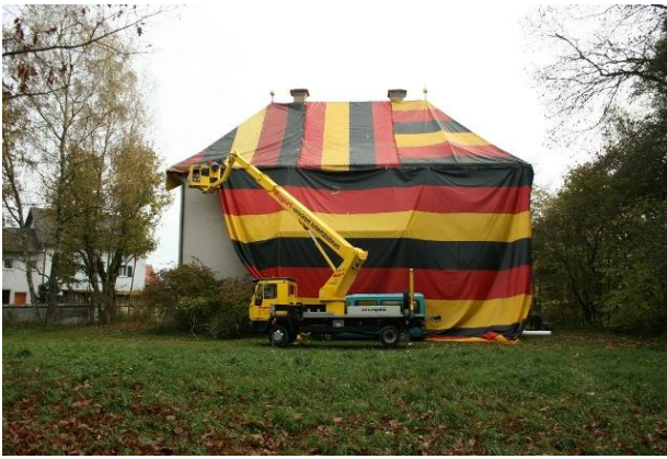
Bild 5: Folieneinhausung des Landschlusses
