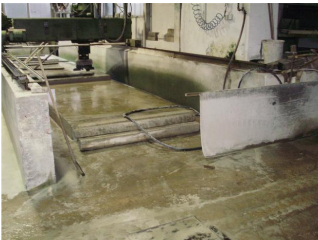
Am vorderen und hinteren Zugang nur Spritwasserschutz, Schleifkopf ohne Schutzhaube
