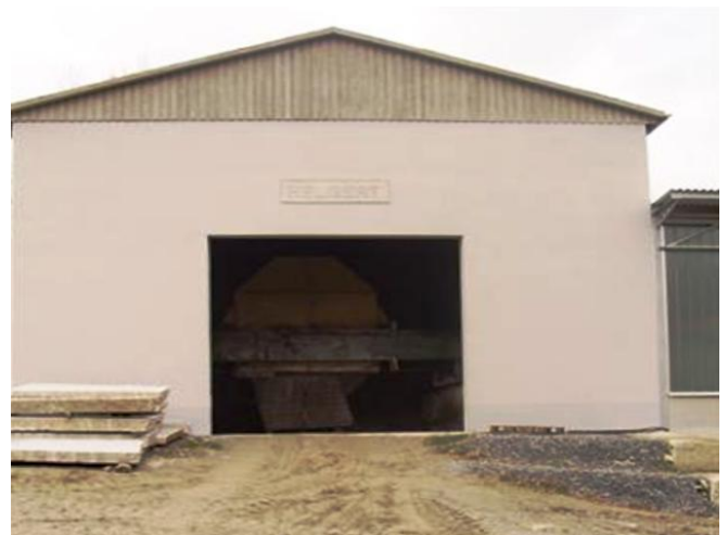
Zugang zur Blocksäge
