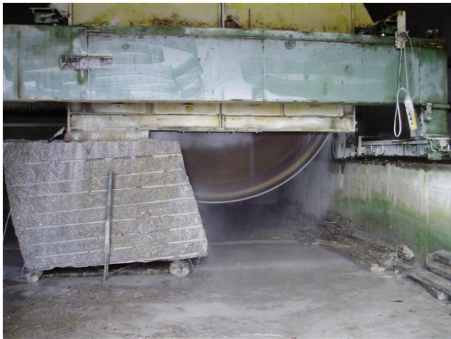
Blick auf die Blocksäge
