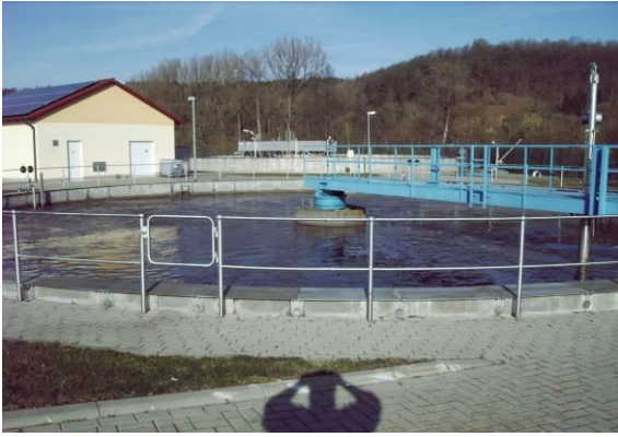
Abb. 2. Nachklärbecken mit nachgerüstetem Geländer
