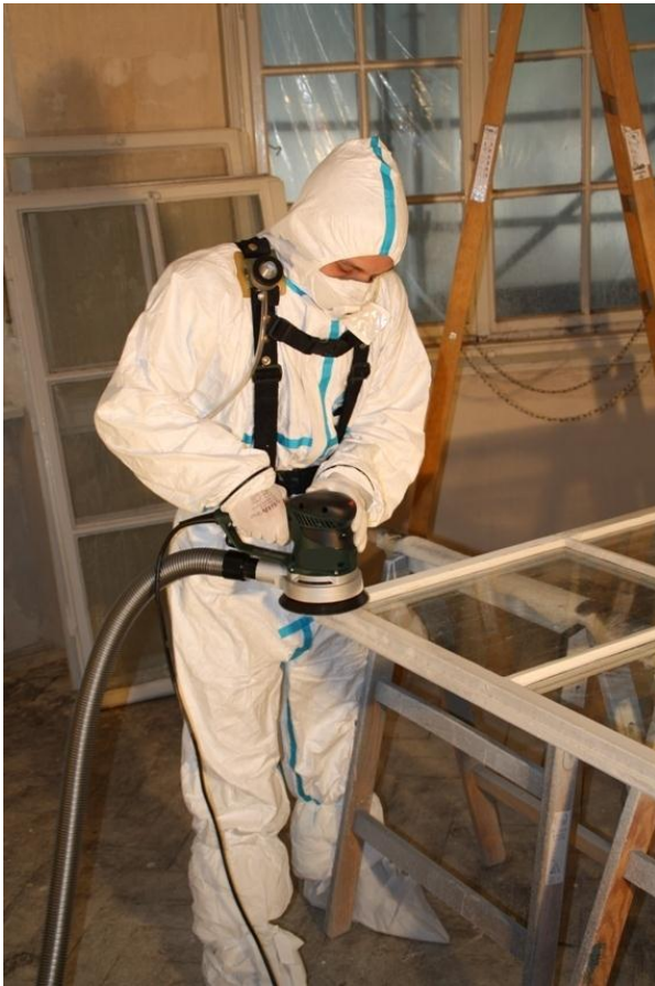
Abb. 4: Personenbezogene Messung beim abrasiven Entfernen bleihaltiger Anstriche von Fensterflügeln
