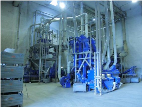
Abb. 2: Maschinenhalle mit Aufbereitungsanlage für Elektroschrott
