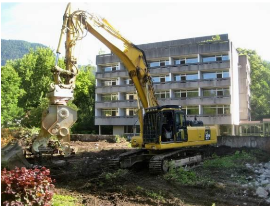
Abb. 1: Als Baumaschinen antransportiert werden, erhält das Gewerbeaufsichtsamt Hinweise über Gefahrstoffe in den abzureißenden Gebäuden
