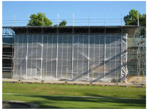
Abb. 3: komplett eingehautes Gebäude: abrasive Bleisanierung einer tragenden Stahlkonstruktion
