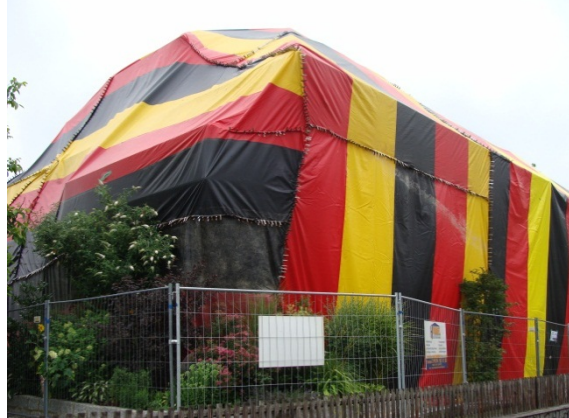
Abb.: In Kunststofffolien eingehülltes Gebäude, das im Inneren mit Sulfuryldifluorid begast ist
