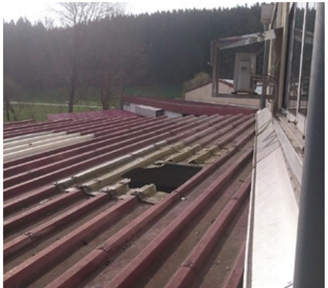
Abbildung 8: Durchbruchstelle des Handwerkers auf dem Weg zum Klimagerät
