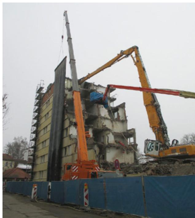
Abbildung 8: Abbrucharbeiten mit Long-Front-Bagger. Als Schutz vor herabfallenden Teilen ist eine Schutzwand, die an einem Autokran hängt, aufgebaut. Zur Staubminimierung wird der Abbruchbereich befeuchtet.
