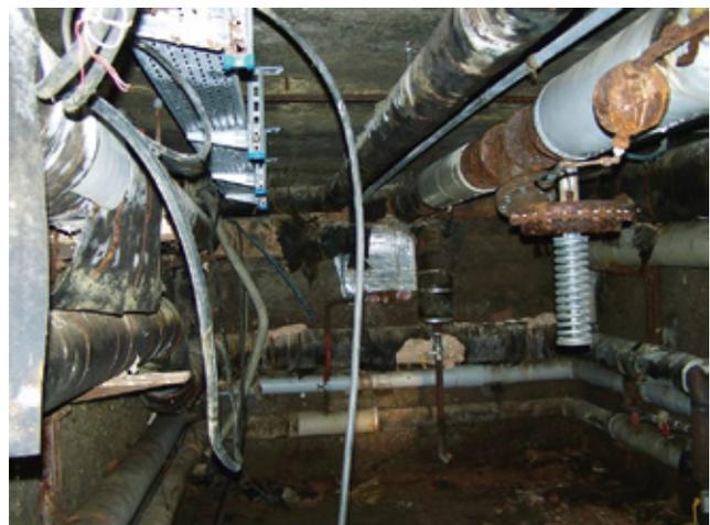
Abbildung 11: Technikraum vor einer Sanierung, in dem zahlreiche asbesthaltige Produkte eingebaut waren
