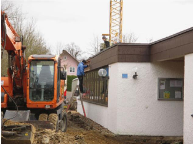
Abbildung 9: Unsachgemäßer Rückbau asbesthaltiger Fassadenelemente: Die Beschäftigten tragen keine persönliche Schutzausrüstung, es fehlen Absturzsicherungen. Die Stehleiter ist für solche Arbeiten kein geeigneter und sicherer Arbeitsplatz.
