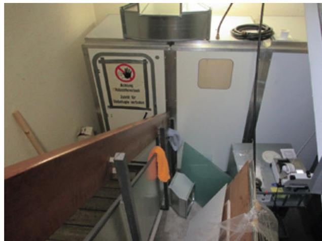
Abbildung 7: Personenschleusen vor einem Asbestsanierungsbereich
