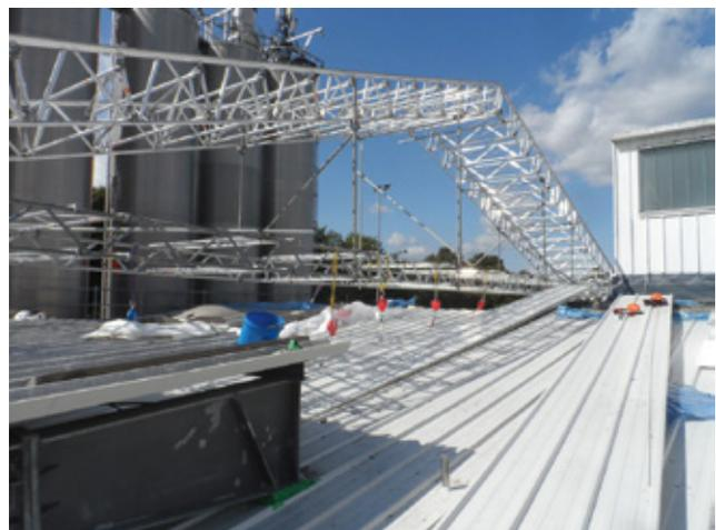
Abbildung 14: Bogengitterträger als zugelassener Anschlagpunkt für die Beschäftigten
