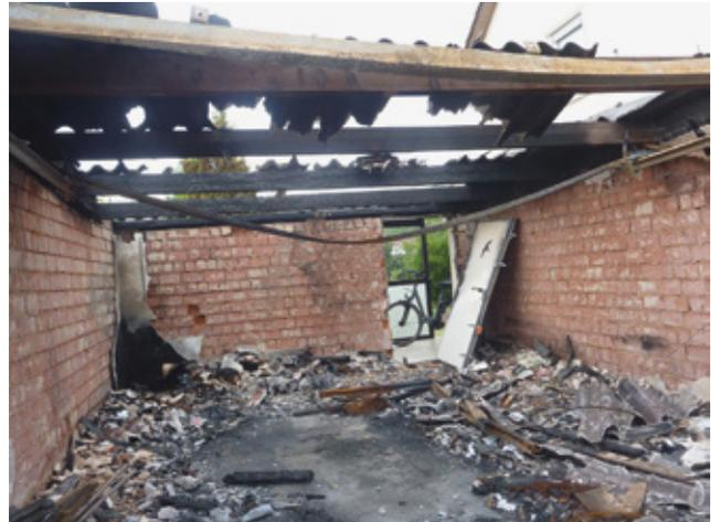
Abbildung 5: Ausgebrannte Garage aufgrund einer defekten Lithiumbatterie
