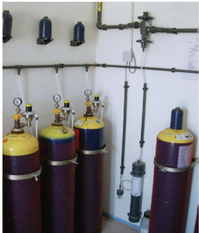
Abbildung 3: Chlorgasraum mit Chlorgasflaschen und Entnahmeeinrichtungen
